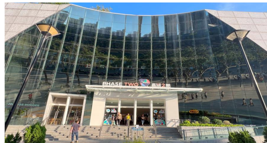
翻新後的入口增設無障礙通道
